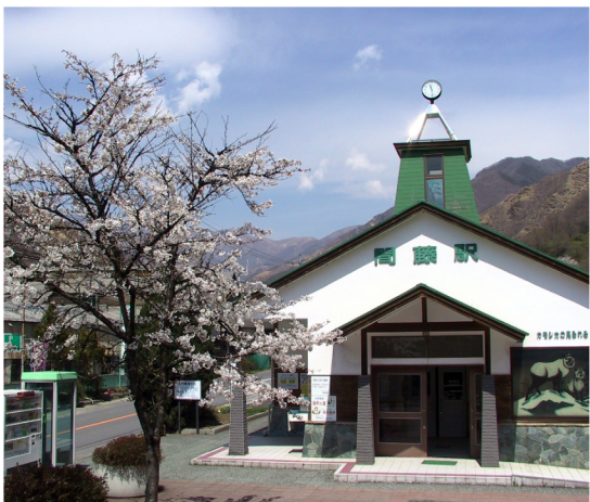
わたらせ渓谷鐵道・間藤駅
